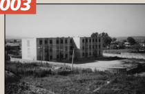
Renovation Mittelschule Levan mit CHF 57'000.–
