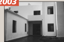
Renovation Kinderkrippe Nr. 56 Tirana mit CHF 128'700.–
