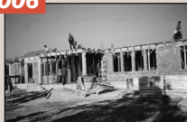
Neubau Schulhaus Kamez mit CHF 195'000.–
