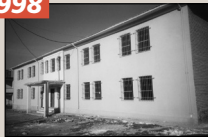
Renovation Kinderkrippe Nr. 48 Tirana mit CHF 70'580.–
