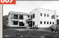
Neubau Schulhaus Vau i Dejes mit CHF 443'344.–
