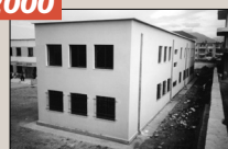
Neubau Schulhaus «1 Qershori» Tirana mit CHF 226'070.–
