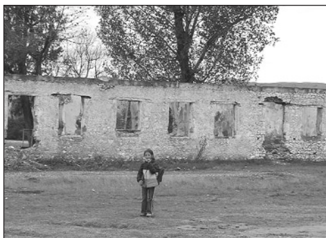
Der zweckdienliche Neubau in Shirq (oben) und die Grundmauern des abgebrannten alten Schulhauses.
